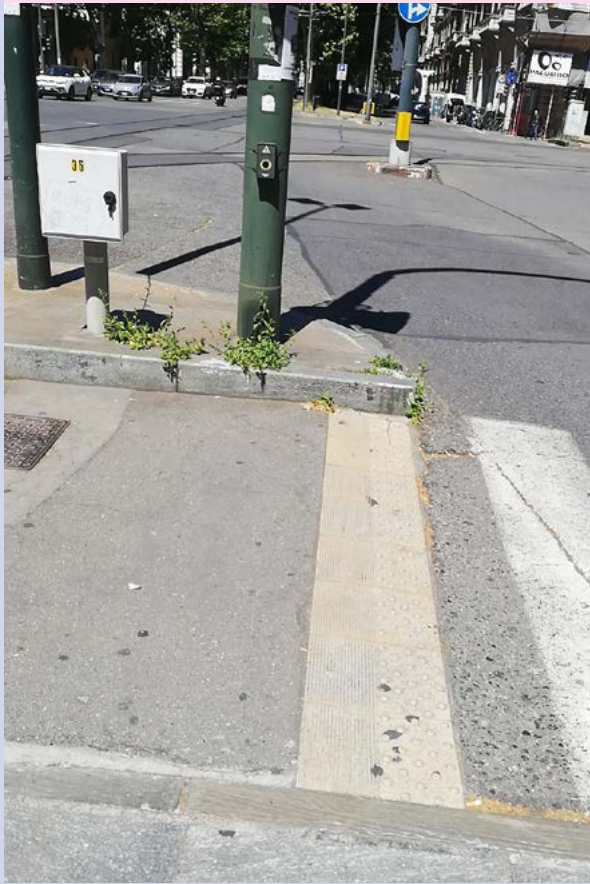
Esempio di attraversamento con semaforo sonoro
