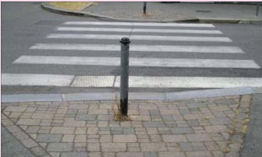
FOTO 15. Il dissuasore di parcheggio è pericoloso per i disabili visivi e un ostacolo per i motori in sedia a rotelle
