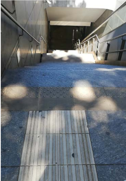
Esempio di ingresso a una stazione della metropolitana con scale
