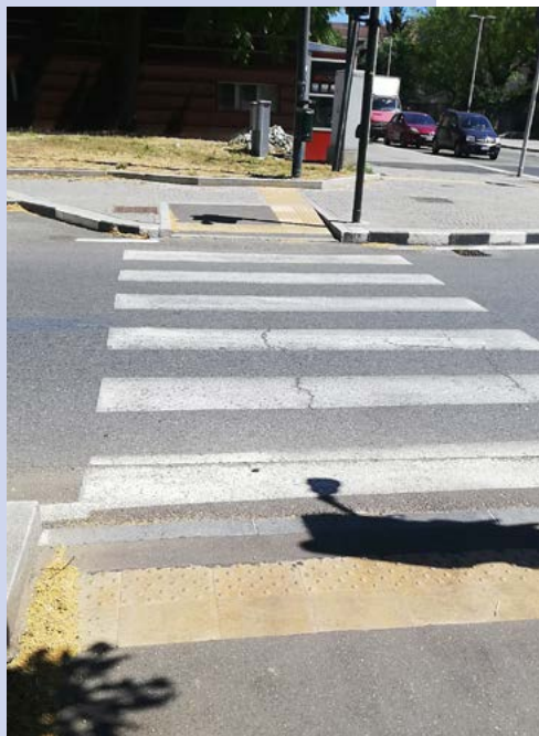
Esempio di area spartitraffico con cordolo e pericolo valicabile più semaforo sonoro
