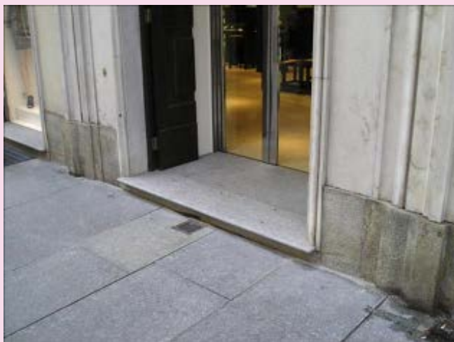
FOTO 32. Il vicino, anche con lo spazio disponibile, ha lasciato un gradino di pochi centimetri, ma sufficienti a renderlo inaccessibile
