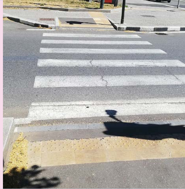
Esempio di area spartitraffico con cordolo, segnale di pericolo valicabile e semaforo sonoro
